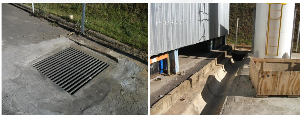
Figura 06: Caixa de passagem de água pluvial e drenagem superficial interna.
