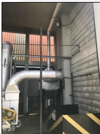
Figura 1: Equipamento de controle de emissões atmosféricas da Caldeira a lenha (policilone).
