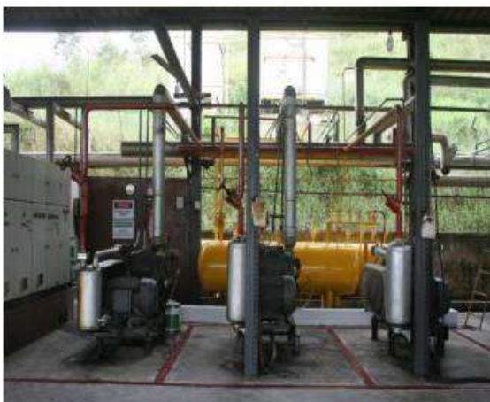
Fig. 19 - Vista do galpão de armazenamento dos Tanques de amônia
