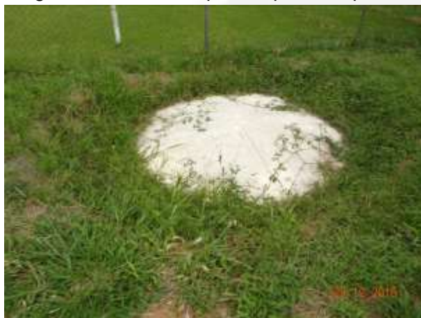
Fig. 10 – Fossa séptica do empreendimento
