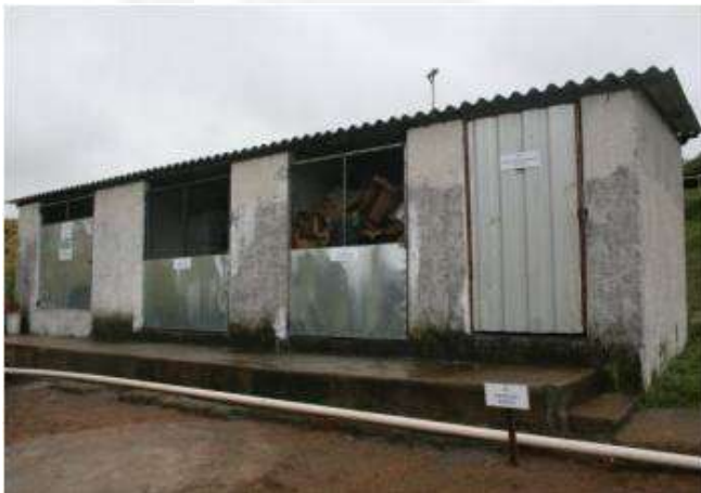
Fig.15 – Depósito temporário de resíduos (DTR).
