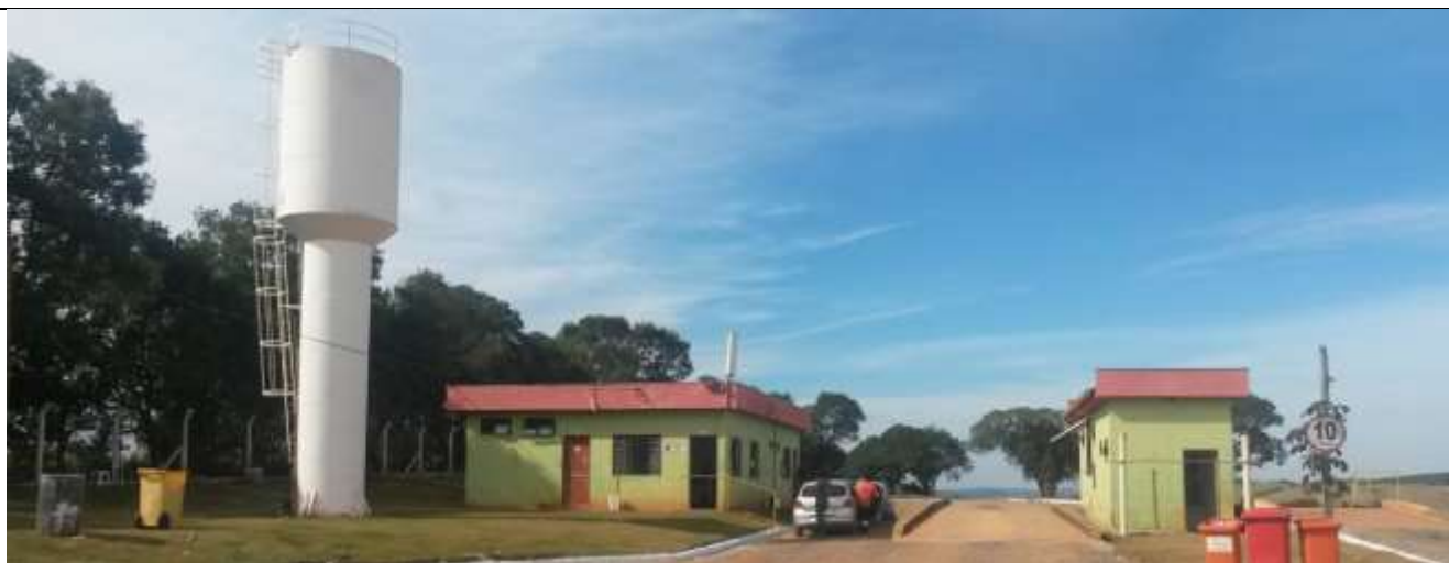
Vista geral: caixa d'água metálica, prédio administrativo, prédio de controle de resíduos e as 02 balanças rodoviárias
