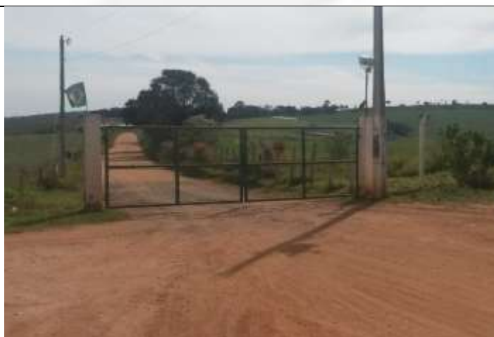
Portão de acesso ao interior do Aterro
