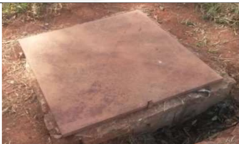
Poço de monitoramento de águas subterrâneas (PMM-01)
