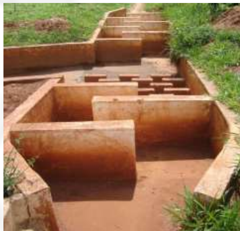
Figura 14 - Dissipador de energia (foto meramente ilustrativa)
