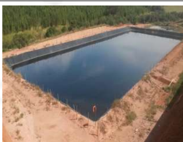
Figura 12 - Lagoa facultativa da ETE. (Fonte: Aterro Sanitário de Alfenas, 2015)
