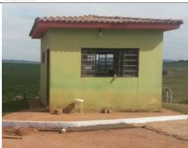
Guarita de controle do acesso ao interior do Aterro
