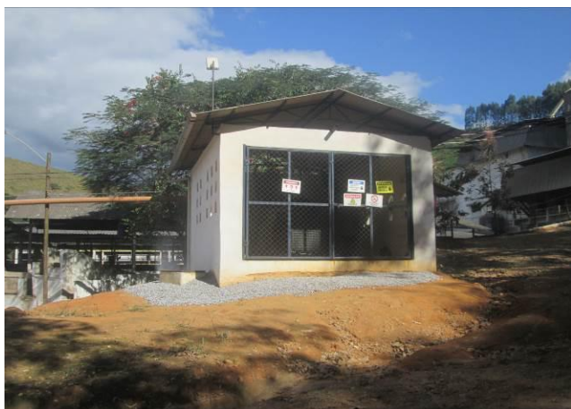
Foto 5: gerador de energia movido a gás com sistema de contenção de possível vazamento de óleo
