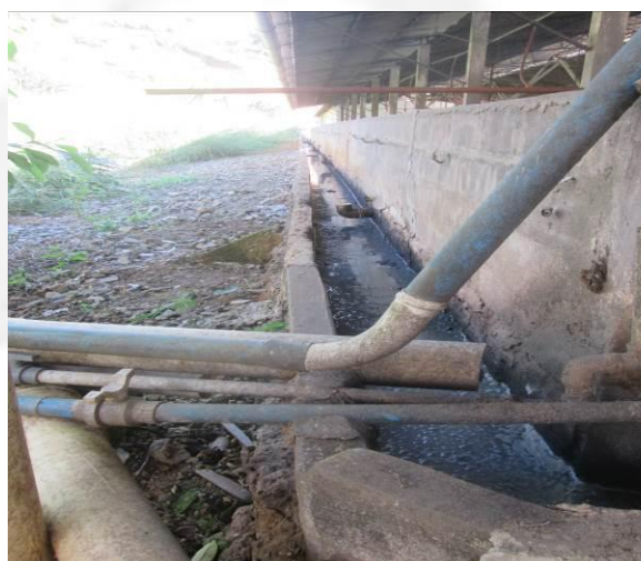
Foto 4: canaleta aberta de galpão conduzindo o efluente industrial
