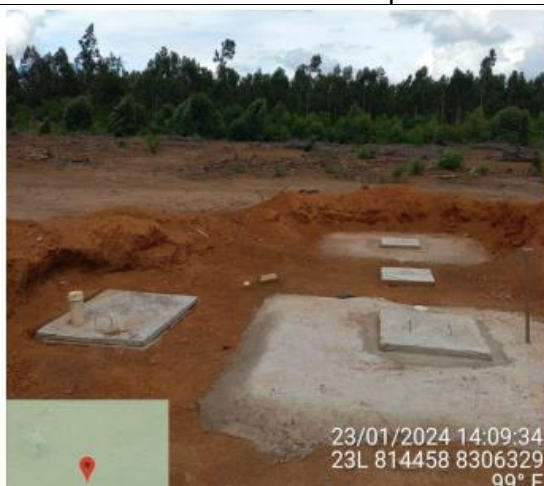
Sistema de tratamento de efluentes domésticos
