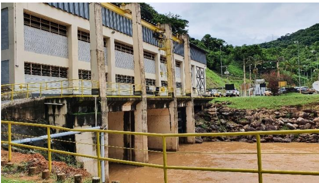
Canal de Fuga
