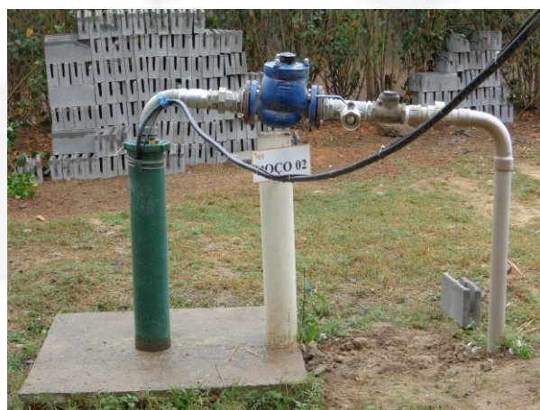
Foto 10. Hidrômetro.
