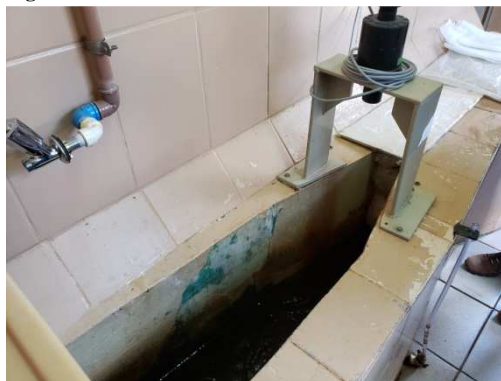
Figura 06. Captação de água - leitura em tempo real
