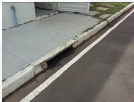
Foto 04. Drenagem pluvial já existente na área.
