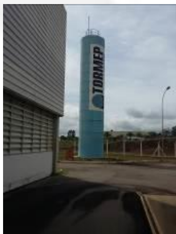
Foto 03. Caixa d'água com capacidade para 100m³ de água.
