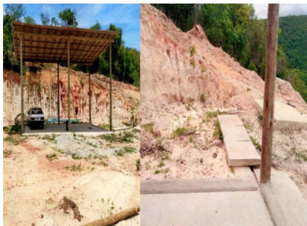
Foto 01 – Galpão com piso impermeabilizado e canaletas, direcionando o fluxo para a Caixa SÃO. Fonte: Autos do PA
