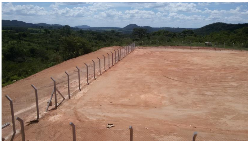
Foto 01. Área de instalação com terra plenagem.
