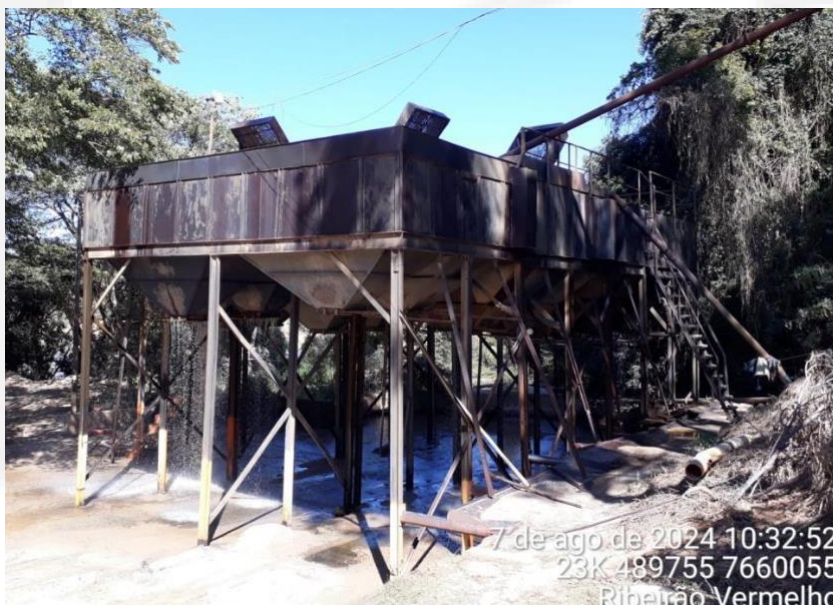
Figura 05: Silo utilizado para armazenamento da areia no porto. Fonte: PCA.
