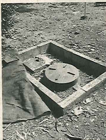
Figura 01. Fossa séptica seguida de sumidouro
