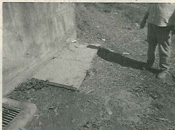
Figura 10. Caixa separadora de água e óleo
