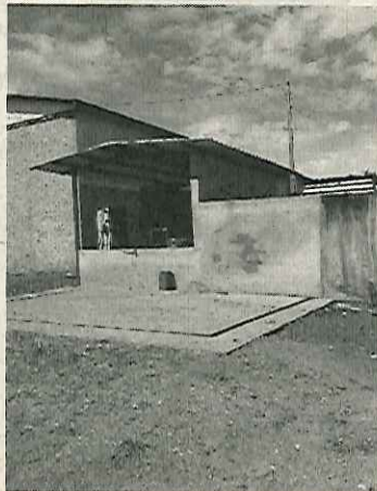
Figura 09. Área de abastecimento de combustível
