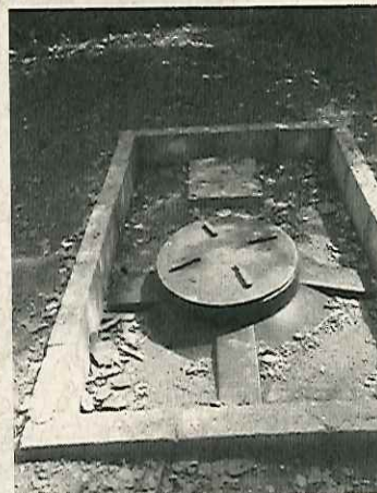
Figura 02. Fossa séptica seguida de sumidouro
