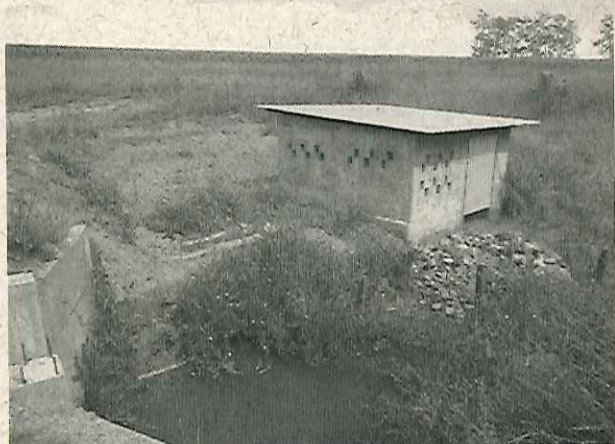
Figura 13. Casa de bombas hidráulicas
