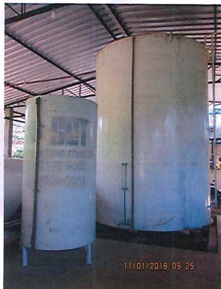
Foto 4: Tanques de armazenamento de solução preservativa.
