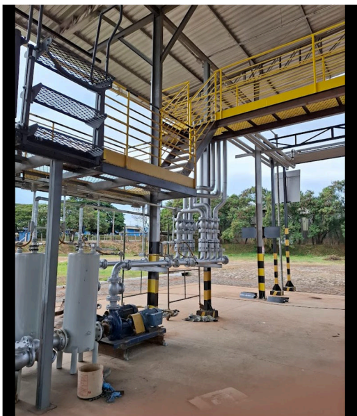
Área de carga e descarga
