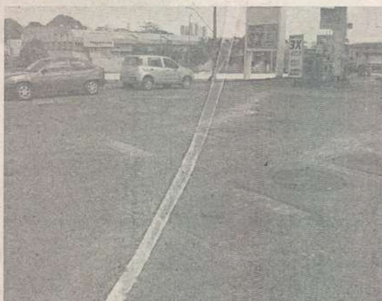
Foto 02. Área dos tanques
