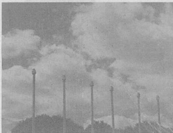
Foto 07. Resp ro dos tanques
