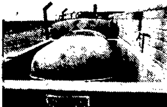
Fig. 13. Depósito de óleo usado e ao fundo reservatório de água a ser reutilizada no lavador
