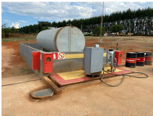
Foto 06. Ponto de abastecimento, com barreira de contenção, piso impermeabilizado e canaletas.
