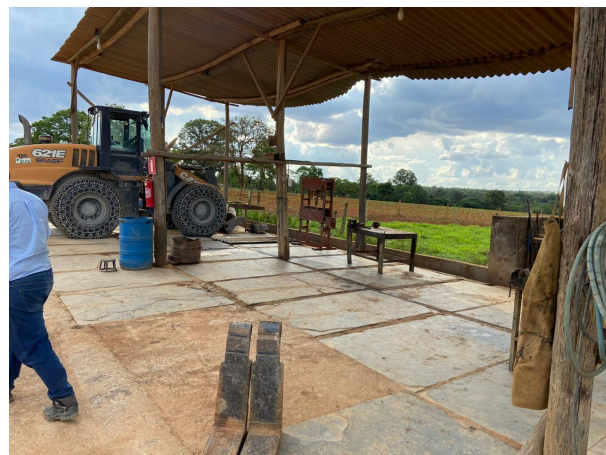
Foto 12. Oficina de reparos com piso impermeabilizado.
