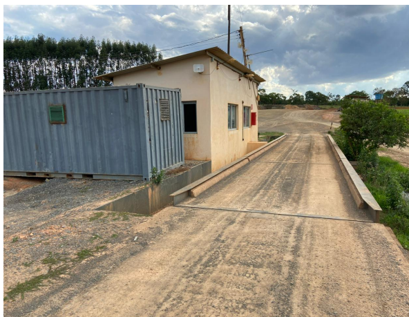
Foto 09. Balança para pesagem de caminhões.
