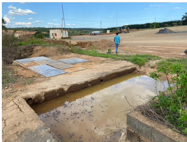
Foto 10. Bacia de contenção com a Caixa SAO ao fundo.
