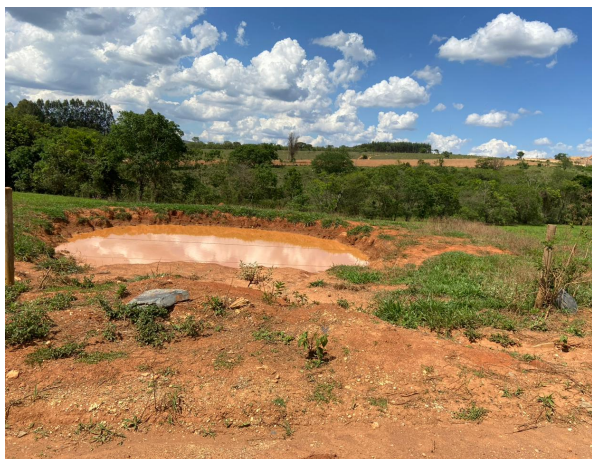
Foto 01. Bacia de sedimentação – Drenagem pluvial.
