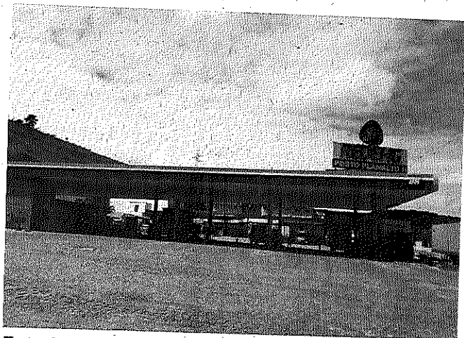
Foto 01: Vista geral do posto.
