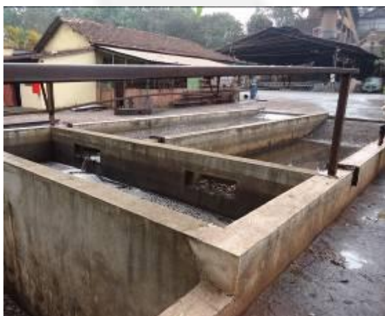
Foto 09. Tanque de decantação de sólidos.
