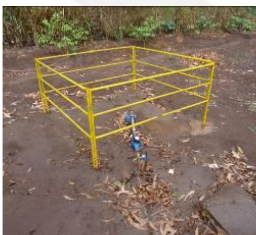
Foto 15. Poço tubular para captação subterrânea
