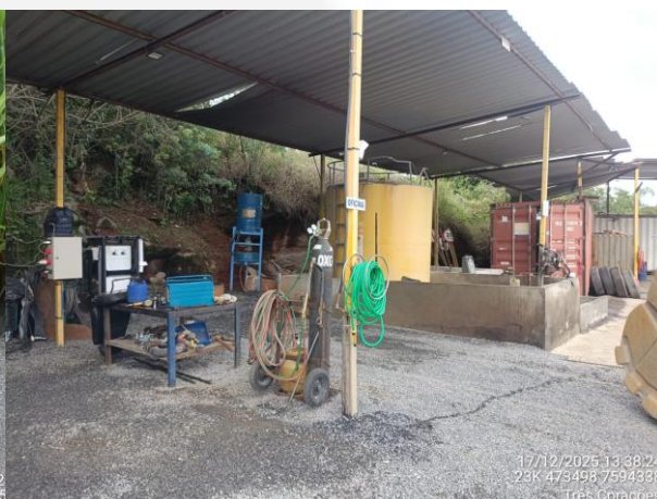
FOTO 6: Oficina sem piso impermeabilizado.
