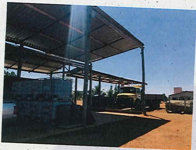
Foto 03. Área impermeabilizada e coberta de armazenamento de produto químico e das vagonetas de madeira
