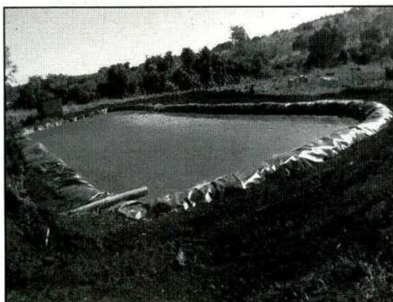
Figura 9: Lagoa de retenção.
