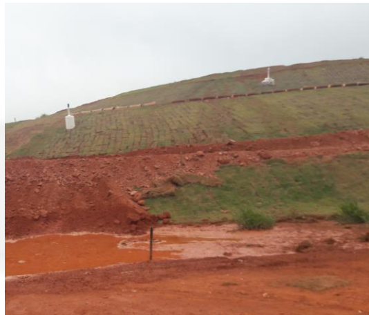
Foto 02. Revegetação de talude
