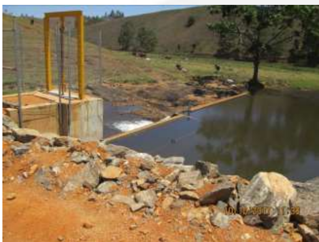
Figura 01: Barramento e tomada d'água.
