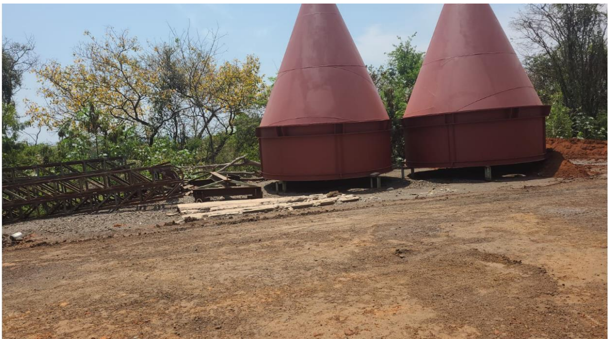
Imagem 03 – Intervensões irregulares na área do empreendimento. Fonte: Auto de Fiscalização nº 228792/2022
