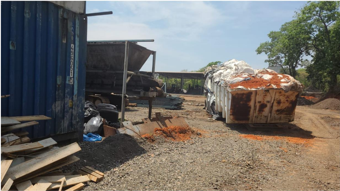
Imagem 02 – Intervensões irregulares na ADA do empreendimento. Fonte: Auto de Fiscalização nº 228792/2022
