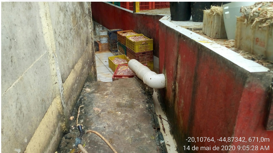
Foto 02 – Disposição de vísceras nas caixas, via canalização.
