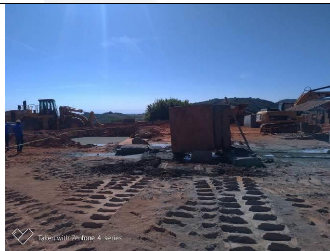
Foto 9: Bacia de contenção da água utilizada no corte da rocha, para ser infiltrada
