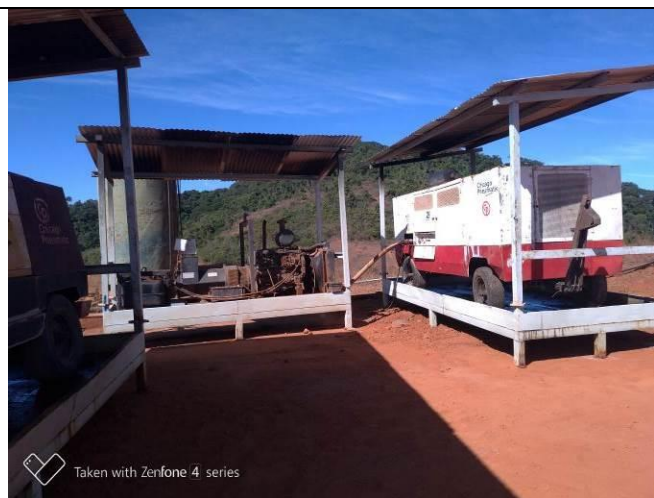
Foto 11: Compressores de ar e gerador de energia em estruturas móveis, com contenção de vazamento
