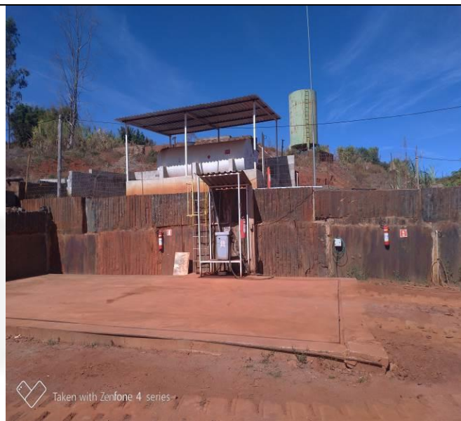
Foto 4: Ponto de abastecimento, com canaletas de contenção de vazamento
