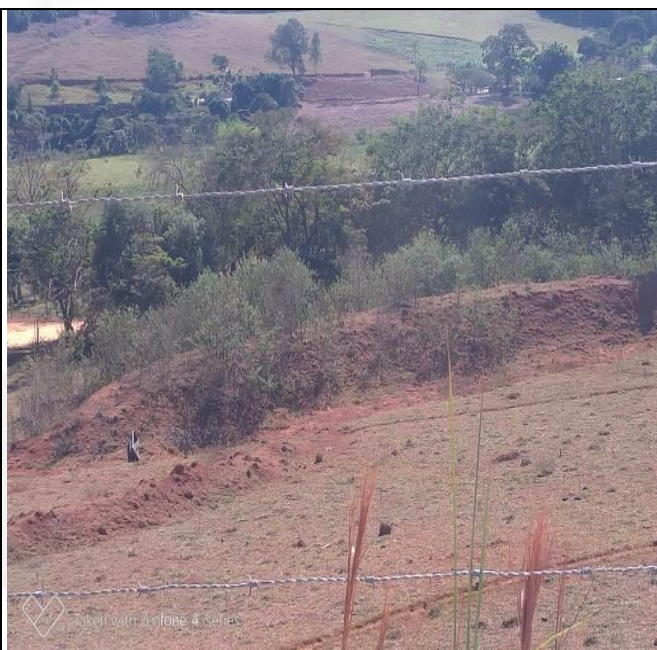
Foto 2: Contenção de sedimentos a jusante da via de acesso ao empreendimento
