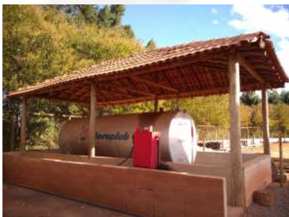
Foto 03: Tanque aéreo de 14.000L
