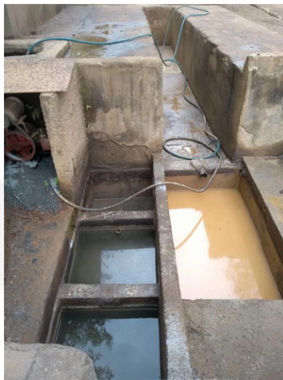
Foto 6: Caixa separadora de água e óleo.
