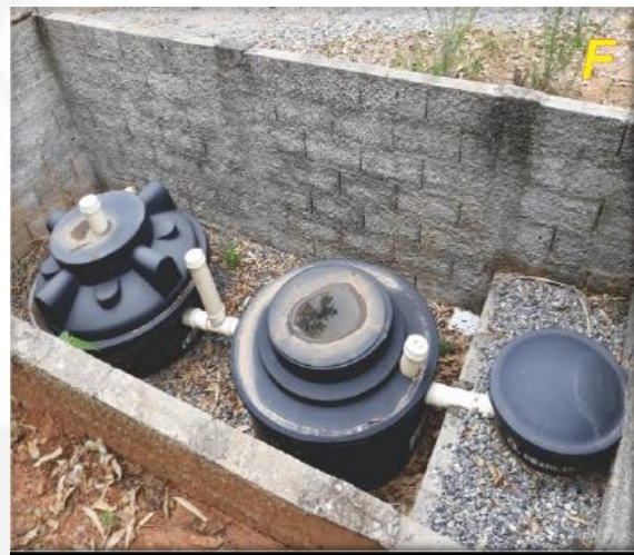
Foto 4: Fossa séptica/filtro anaeróbio
