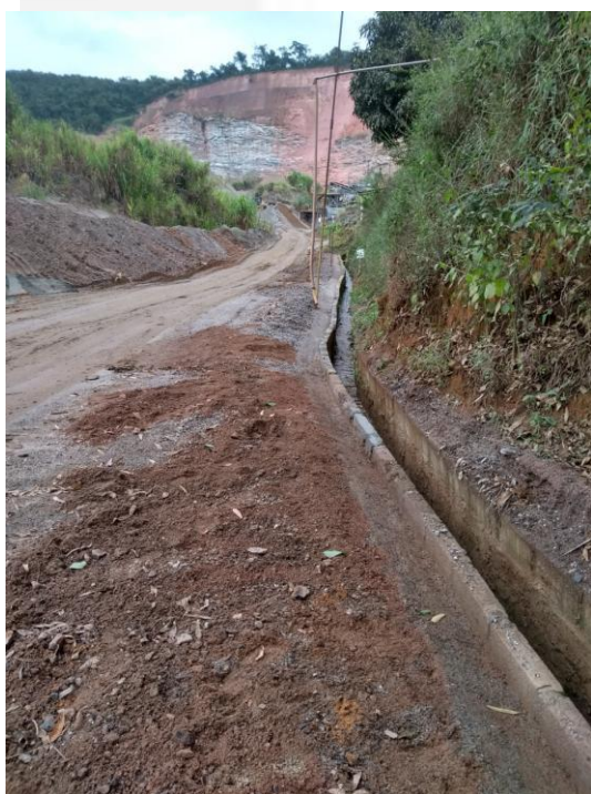
Foto 11: Sistema de drenagem pluvial da parte baixa
