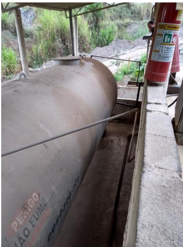
Foto 9: Tanque aéreo de combustível, com cobertura e bacia de contenção de vazamentos
