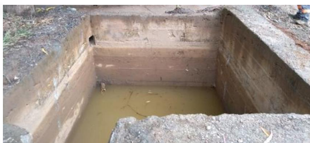
Foto 12: Sistema de drenagem pluvial/Caixa de decantação da parte baixa
