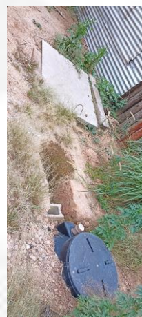
Foto 08. ETE sanitária (biodigestor e sumidouro)
