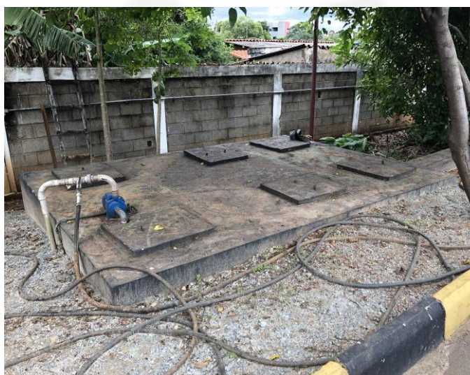
Foto 08. Tanque de acúmulo de água contaminadas para o uso no processo.
