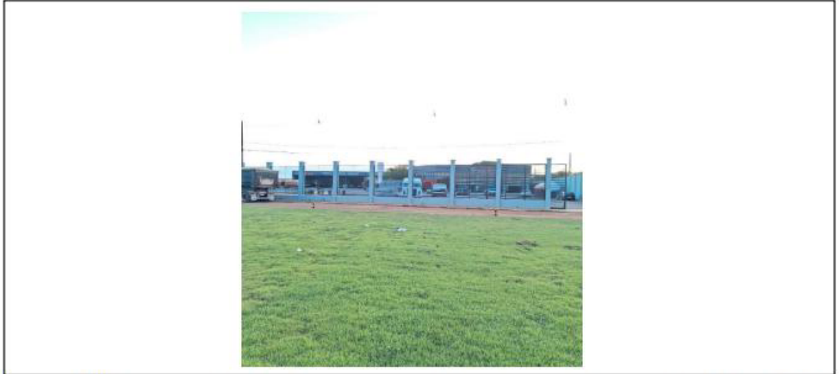
Imagem 01: Vista exterior frontal da área do empreendimento onde será instalado o posto revendedor. Autor: Esfera Ambiental Eireli, setembro de 2023.
