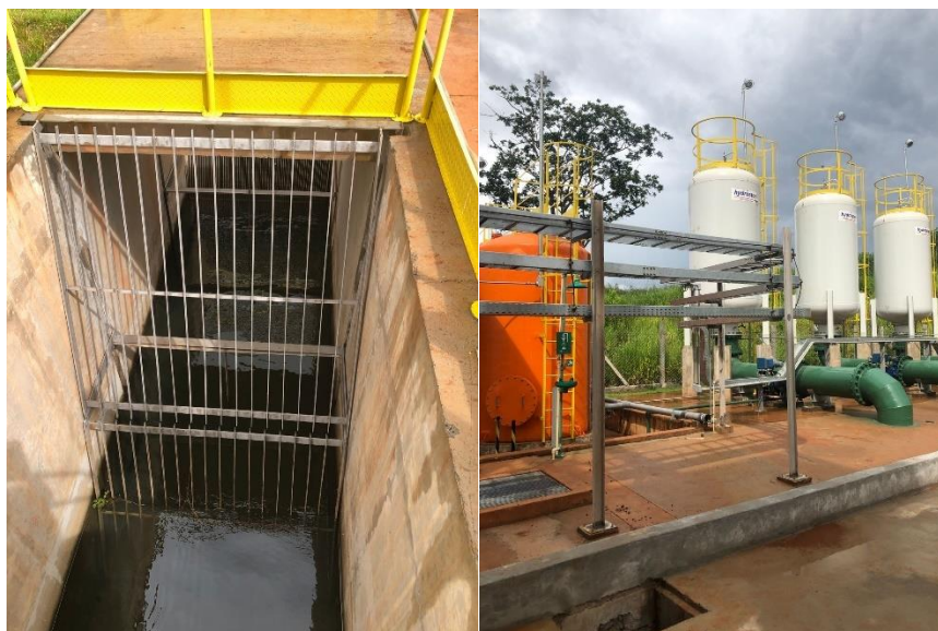
Figura 2-3 Gradeamento e tratamento de água captada
