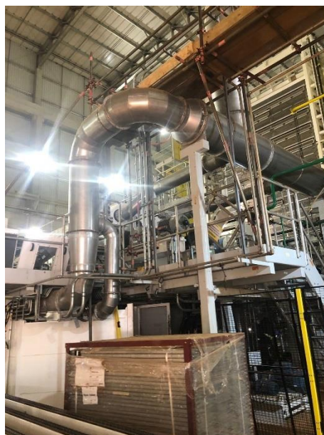
Figura 2-2 -Bacia de contenção e sistema pipe rack
