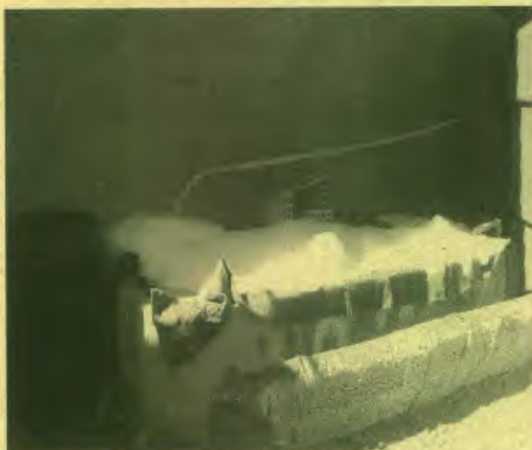
Foto 15: Transbordamento da ETEI sobre o leito de secagem Foto 16: Leito de secagem
