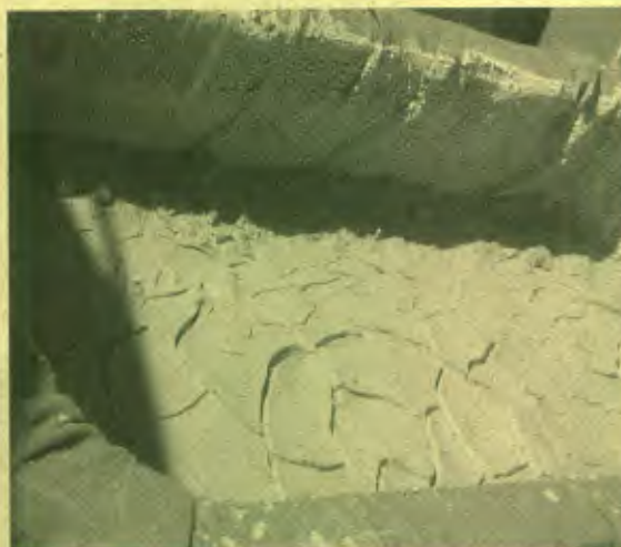
Foto 15: Transbordamento da ETEI sobre o leito de secagem Foto 16: Leito de secagem
