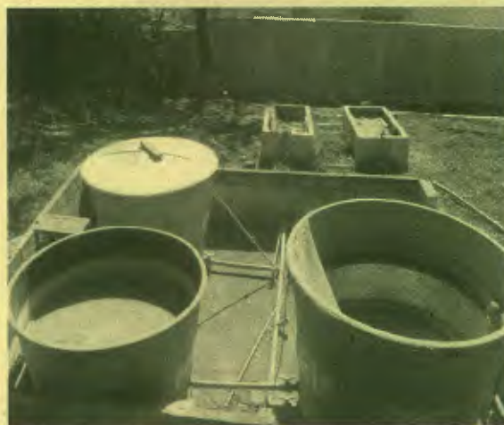
Foto 5: Antiga ETEI - atual tanque de sedimentação
