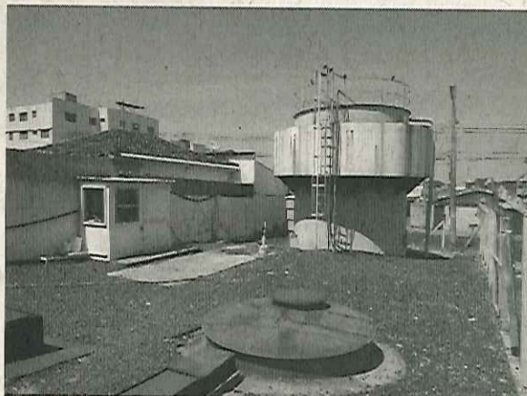
Foto 02. Vista da ETE.
