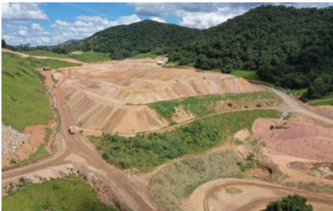
Figura 11 - Imagem dos taludes da pilha de estéril Belém em recuperação
