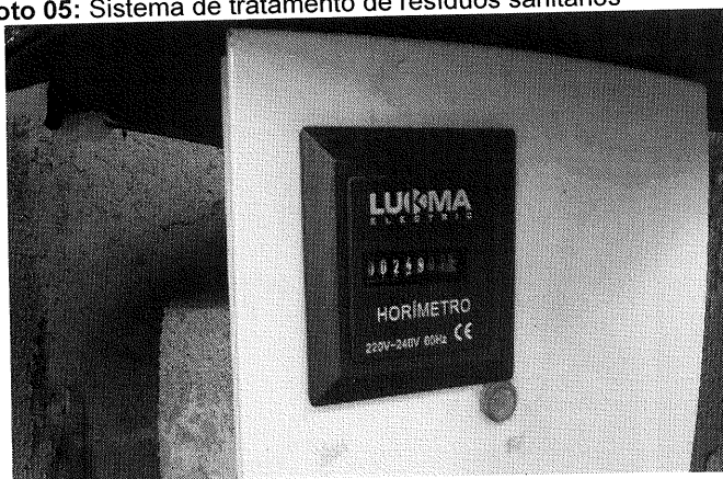
Foto 07: Horímetro do poço artesiano
