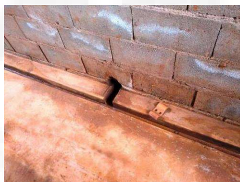
ANEXO V.4 - Canaletas de drenagem e piso impermeabilizado na oficina de pequenos reparos.
