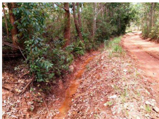
ANEXO V.9 - Estrutura de drenagem da estrada de acesso.
