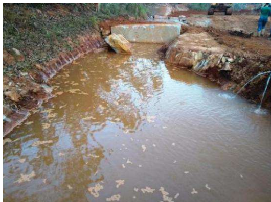
ANEXO V.7 - Bacia de contenção de sedimentos da cava.
