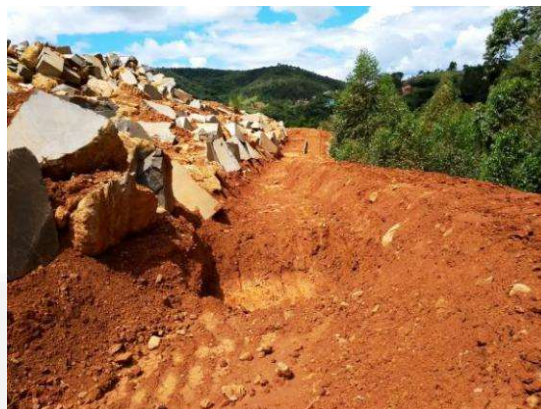
ANEXO V.8 - Estruturas de contenção de sedimentos na pilha de estéril/rejeitos.
