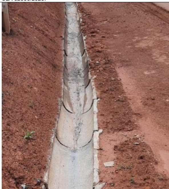
Foto 04: Canaletas de drenagem instaladas. FONTE: Processo SLA 32836/2025.
