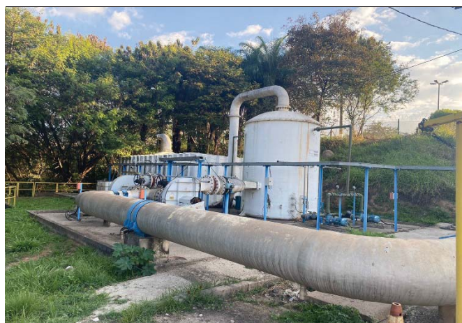
FOTO 8 – Adensadores por flotação.
