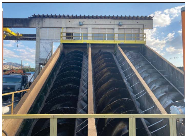
FOTO 5 – Elevatória de lodo.
