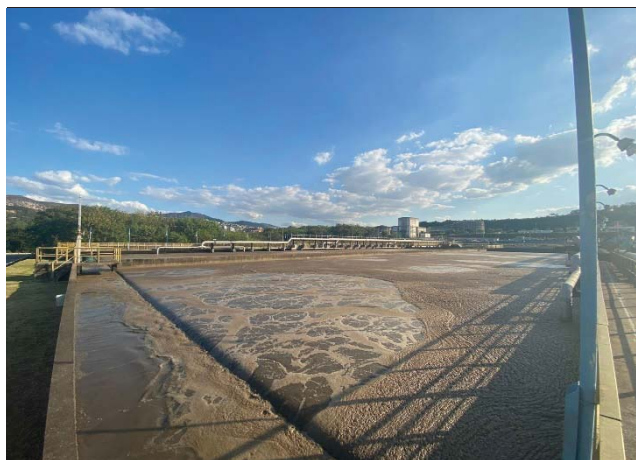
FOTO 3 – Tanque de aeração (reator).
