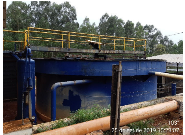
Foto 06. Tanque de flotação (ETE)
