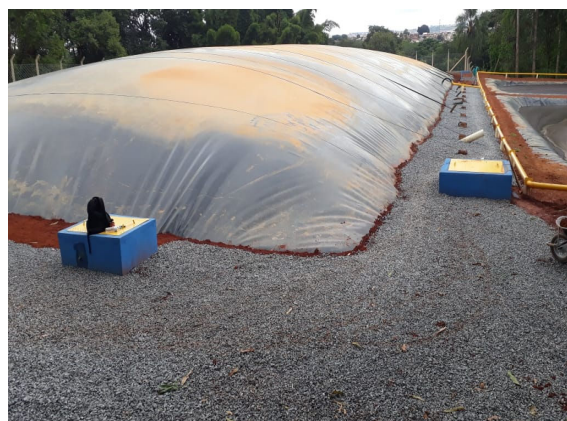
Figura 02 - Biodigestor em operação
