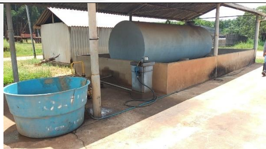
Foto 05: Tanque Aéreo de armazenamento de diesel.
