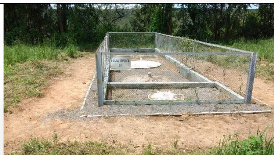
Foto 03: Sistema de tratamento de efluente sanitário - Sede
