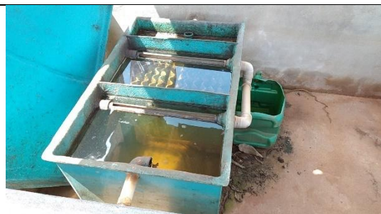
Foto 16: CSAO da area de apoio da carbonização.
