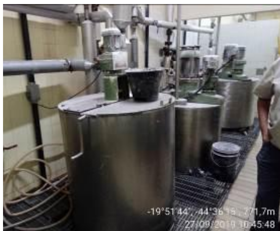
Foto 09. Recirculação efluente industrial (não havendo descarte)
