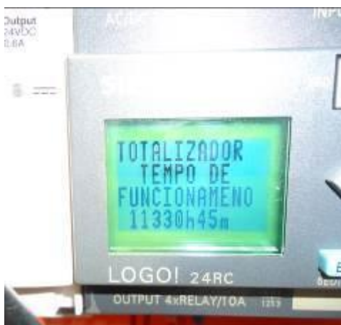
Foto 11. Temporizador para limitar a captação de água conforme Outorga
