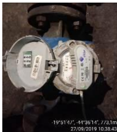
Foto 12. Hidrômetros instalados nos poços.
