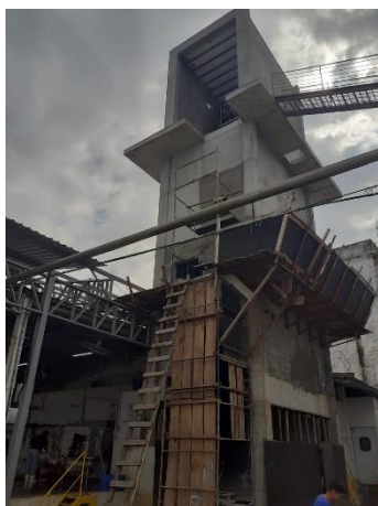
Foto 03. Ampliação da torre de resfriamento de água
