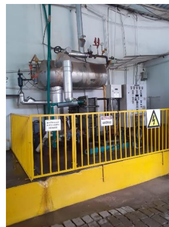
Foto 04. Tanques de amônia
