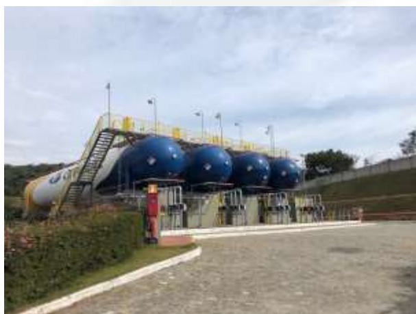
Foto 01. Tanques de armazenamento de GLP: dois em operação e dois objetos deste processo de LO .
