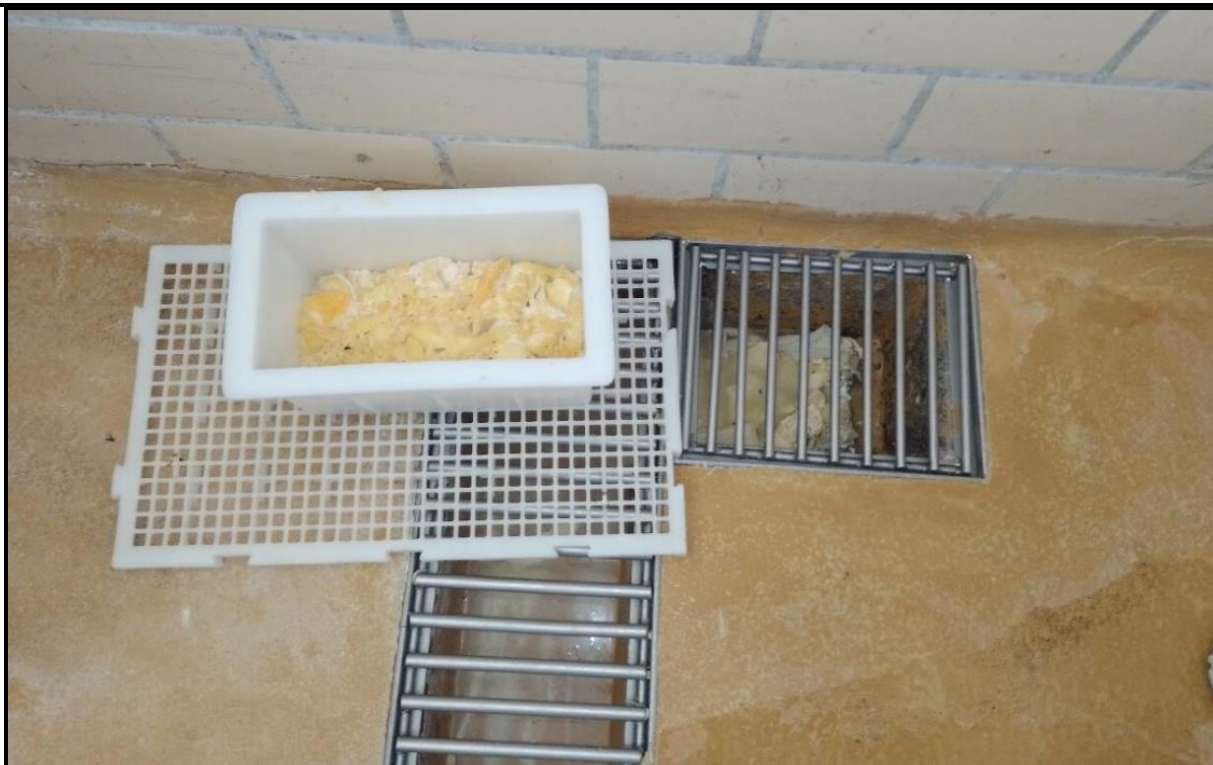
Figura 04 – Retenção de massa de queijo na produção
