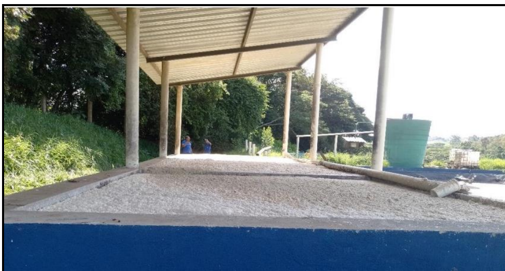
Figura 08 – Leito de secagem do lodo da caixa de gordura
