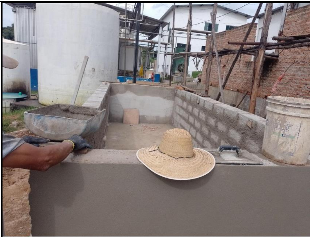
Figura 05 – Construção da nova bacia de contenção
