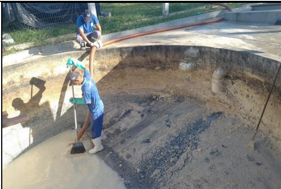
Figura 07 – Limpeza do tanque de equalização
