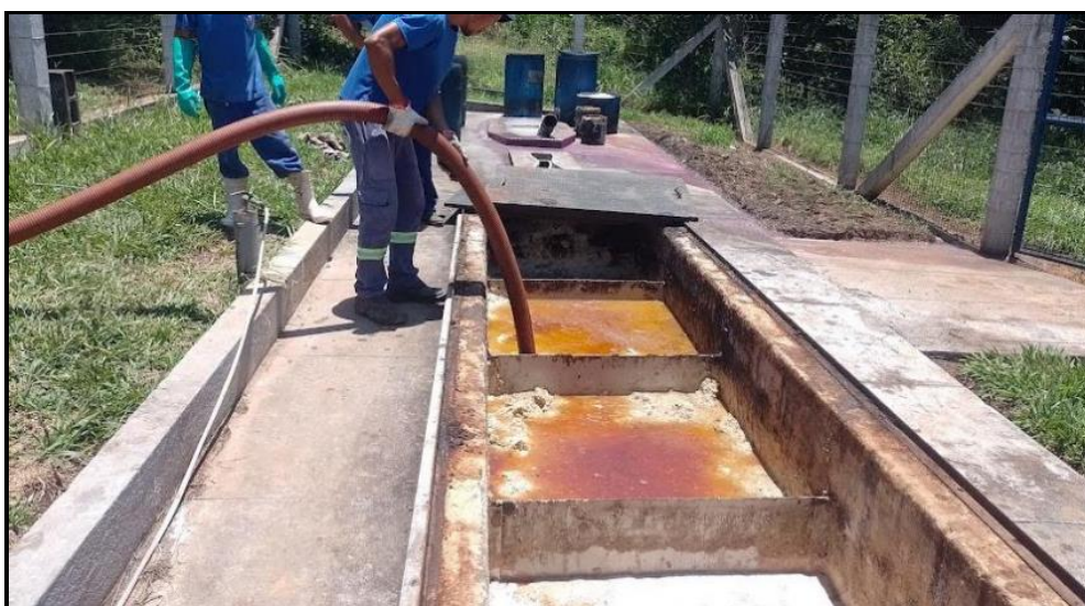
Figura 06 – Limpeza das caixas de gordura
