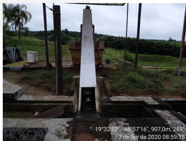
Foto 02. Recolhimento dos sólidos retirados do desarenador aerado
