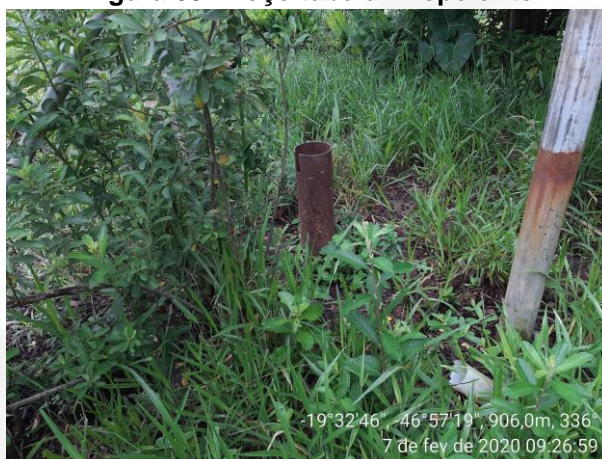
Figura 03 - Poço tubular inoperante
