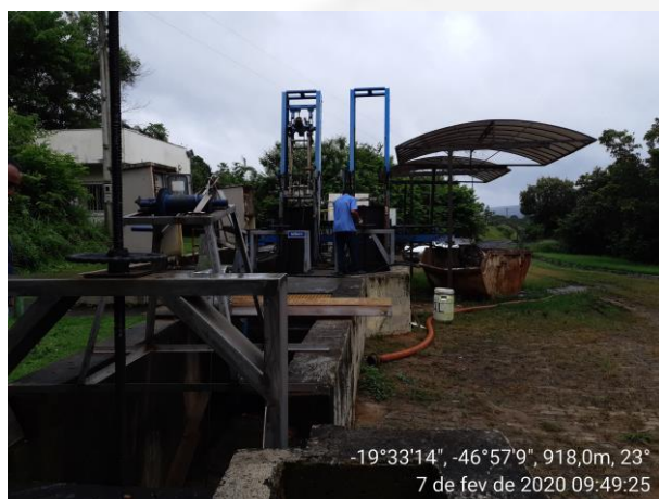
Foto 01. Tratamento preliminar - gradeamento e peneiramento
