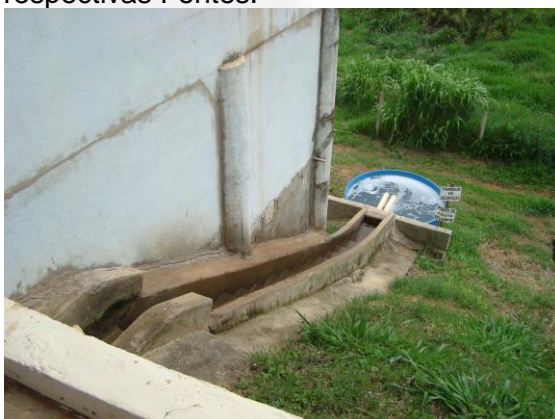
Foto 11. Sistema (escada e tanque de neutralização) de efluente industrial (água do processo produtivo).
